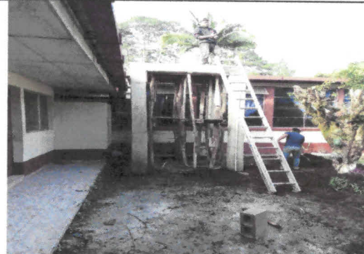
Foto 4: Colocación de base de concreto para tinacos, útiles para la distribución de agua en los servicios sanitarios.
