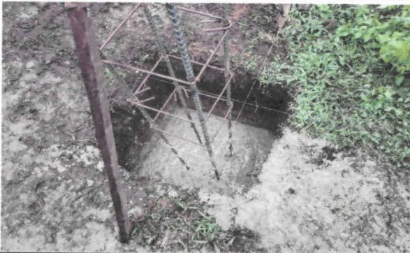
Foto 3: Colocación de base de concreto para tinacos, útiles para la distribución de agua en los servicios sanitarios.
