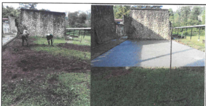
Foto 6: Losa de patio .
