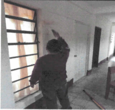
Foto 1: Pintura interior en paredes de biblioteca, es necesaria la aplicación de pintura en paredes ya que se están deteriorando.
