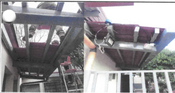
Foto 5: Cambio de techo de teja, necesario por el deterioro de la teja que actualmente tiene.
